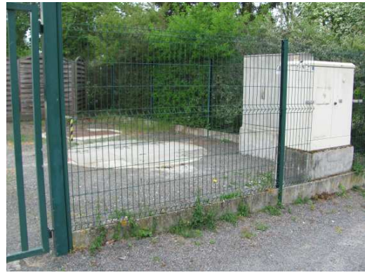
Poste de refoulement « Graviers »
