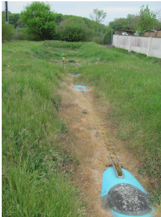
Station d'épuration de « la Babinière »
