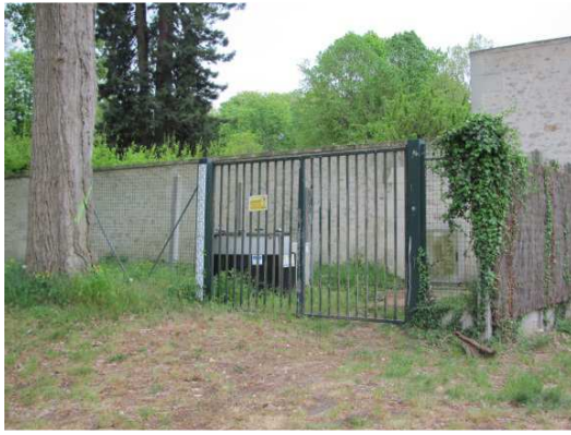
Poste de refoulement du bourg
