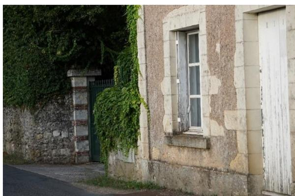
Photo 9 : pilier en pierre de calcaire et en briques.
