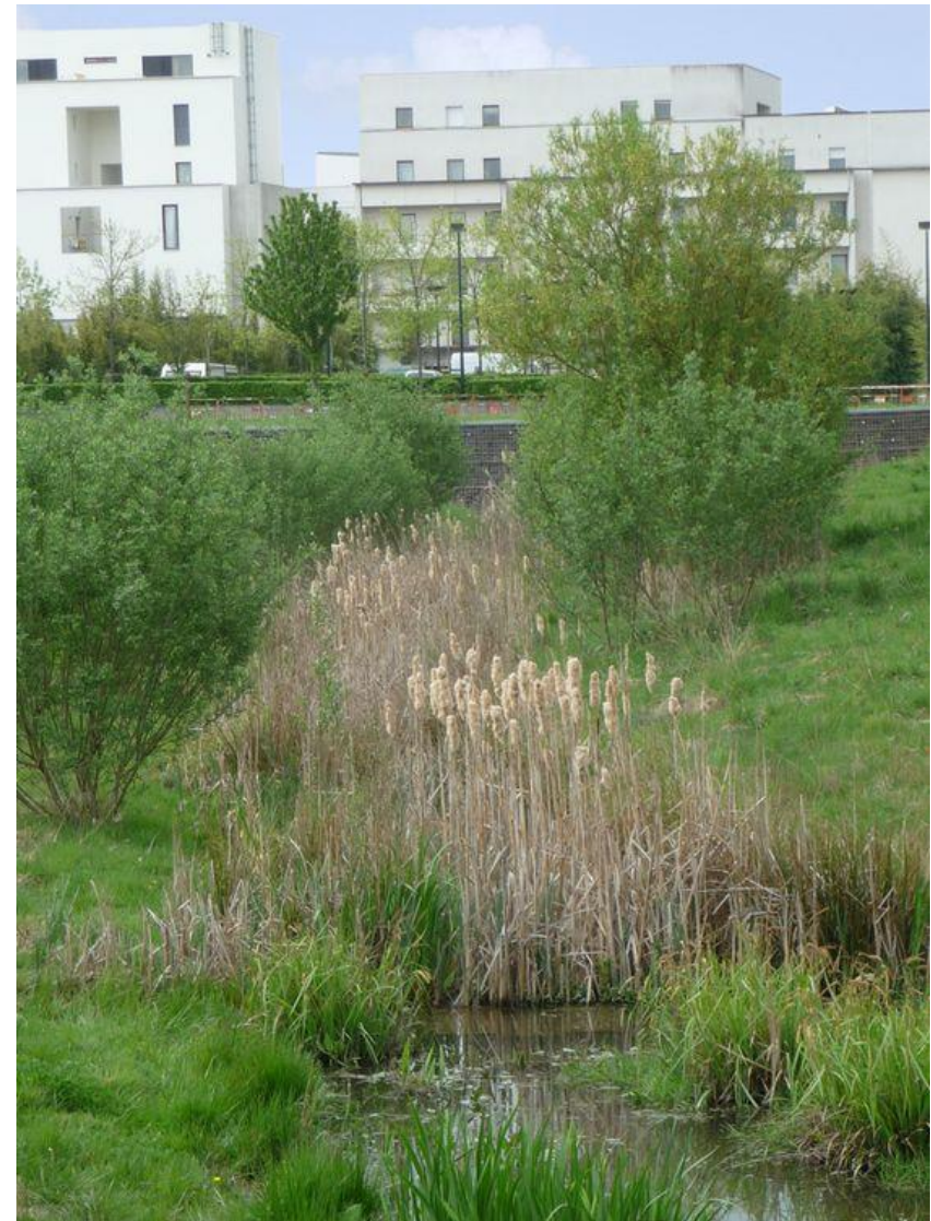
Aménagement d'un espace végétalisé et arboré en lien avec le relief naturel. Fossé de récupération des eaux pluviales en point bas
